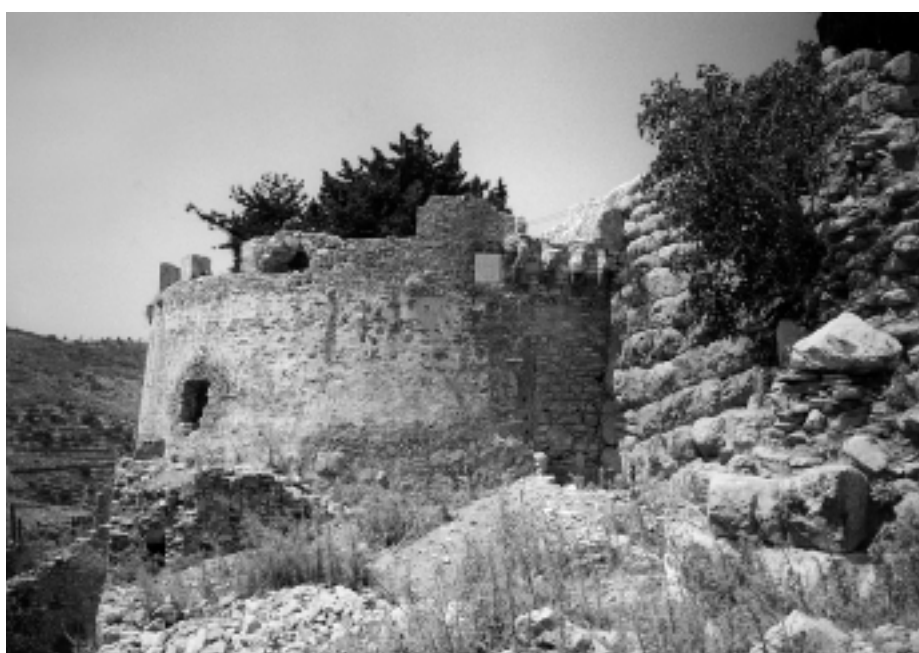
8: Sými, Kástro, grosses Rondell mit Wappen des Grossmeisters Emery d'Amboise, rechts anschliessend Teilstück der hellenistischen Ringmauer.
