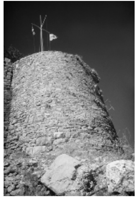
11: Sými, Kástro, kleines Rondell. Deutlich erkennbar sind die hellenistischen Quader in Zweitverwertung.
