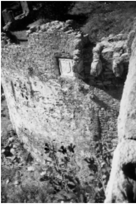
9: Sými, Kástro, grosses Rondell mit Wappen des Grossmeisters Emery d'Amboise, rechts neben dem Wappen Maschikuli-Konsolen, Blick von der antiken Ringmauer.
