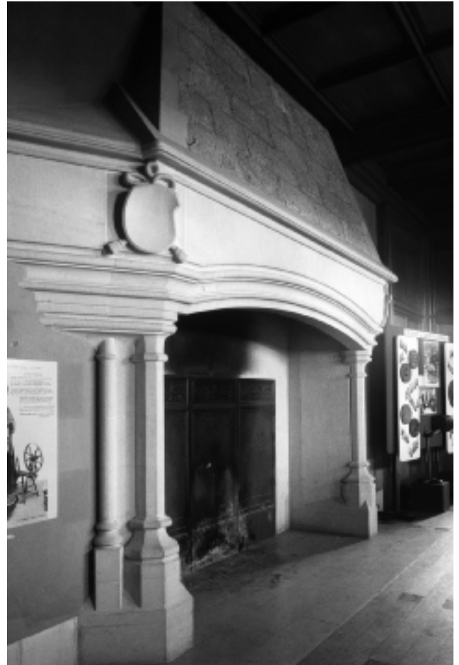
7: Cheminée d'Amédée VIII, reconstruite en matériaux modernes.
