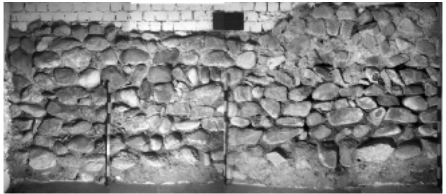
Cham ZG, Kapelle St. Andreas. Ansicht an die Westmauer des ältesten Bauwerks im Kellerraum unter der Kapelle. Die Mauer stammt von einem Profanbau, der älter als die Kapelle des 12. oder 13. Jahrhunderts ist (Kantonsarchäologie Zug, Peter Holzer).
